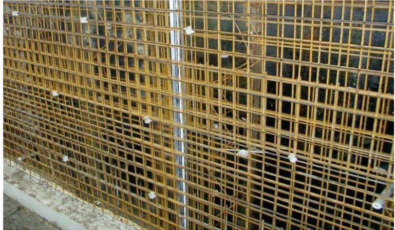
Am Fußpunkt ist das SynkoElast® Sollrissprofil stumpf auf die vorhandene horizontale SynkoElast® Abdichtung aufzusetzen und fest einzudrücken, so dass sich die Dichtungsbänder miteinander verkleben
