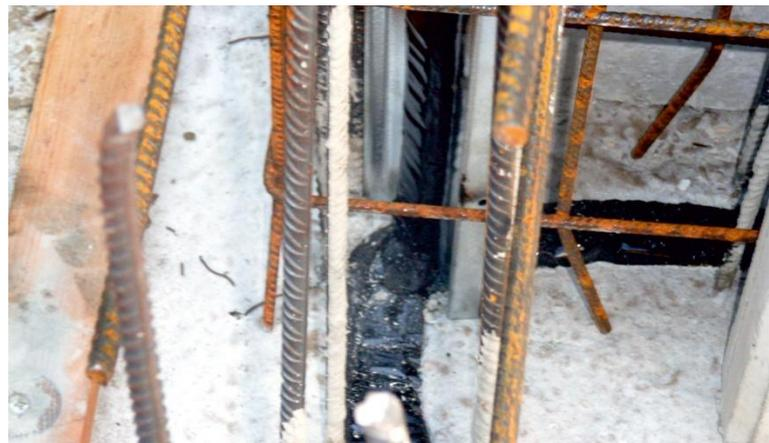
Anschließend wird das Sollrisselement an der vorhandenen Bewehrung einseitig mittels Bindedraht fixiert. Beim Einsatz in Elementwänden ohne Zulagebewehrung im Stoßbereich wird das SynkoElast® Sollrissprofil mit dem GFK Fixierstab in Wandstoß fixiert.
