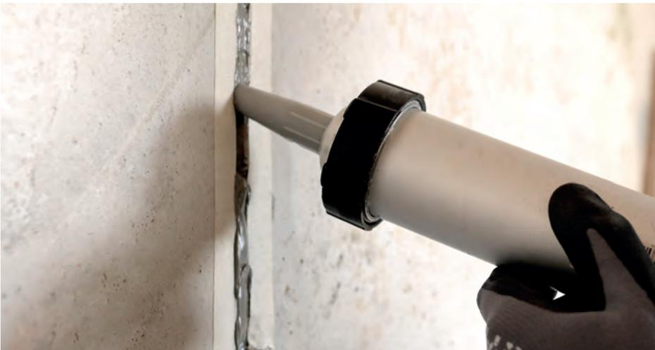
**InnoElast® Typ 1** wird in die Fuge eingefüllt
