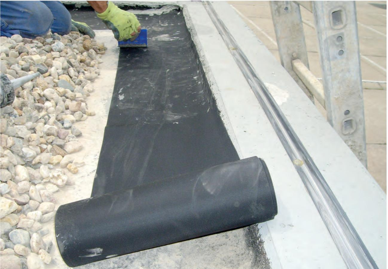
ProElast® als streifenförmige Abdichtung
